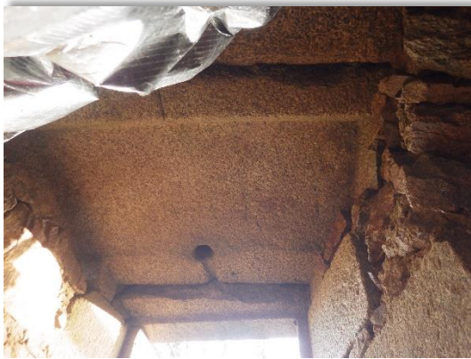
La pierre d'évier en réemploi derrière le linteau de l'entrée (conduite d'eau au premier plan)
