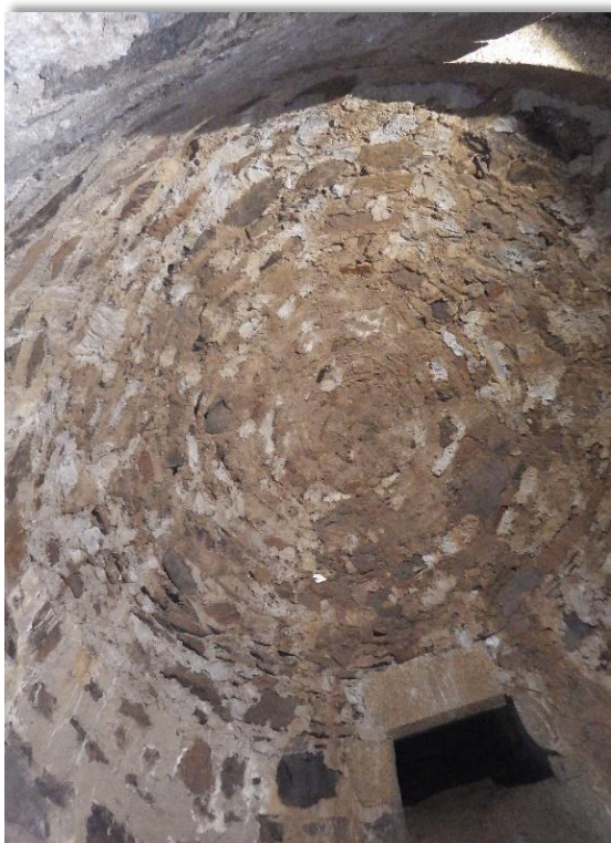
La voûte du corps de la glacière et le débouché de la trappe à glace.
